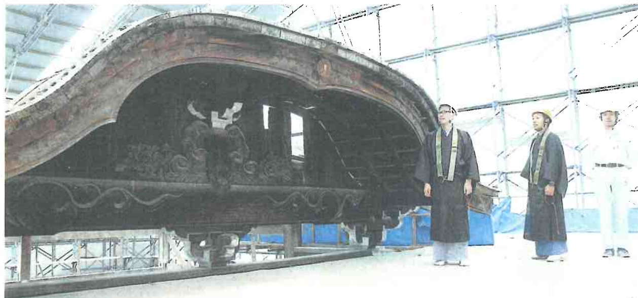
瓦などが取り外された大玄関の唐破風=いずれも船場本徳寺
